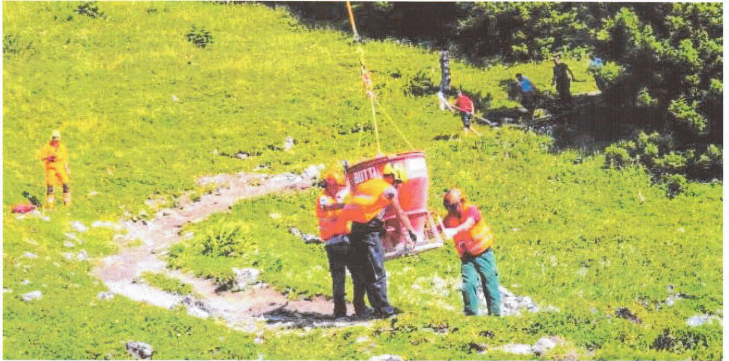
In großen Betonkübeln wurde der benötigte Schotter per Heli angeliefert.
